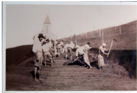
Mutirão construção estrada acesso à Igreja de Jequitibpa, 1949
