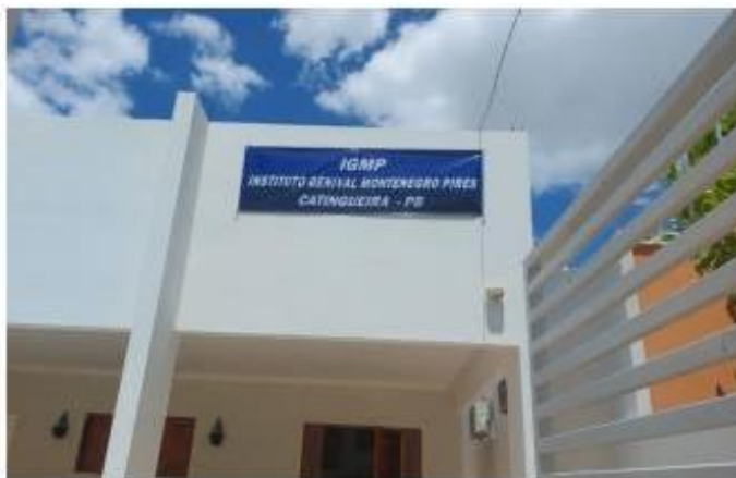
Prédio da Sede do Instituto na cidade de Catingueira/PB
